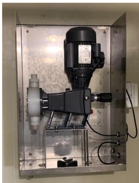
Figura 21: Pompa de acid sulfuric (stânga) și rezervorul de acid sulfuric (dreapta)
