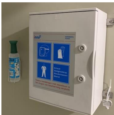
Figura 6: Duș de urgență și cabinet de siguranță
