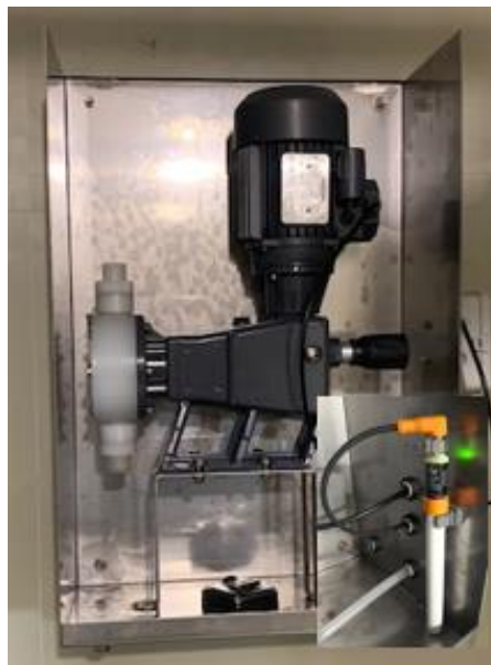
Figura 5: Pompă de acid sulfuric
